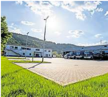
Das THW Saarburg weicht die neue Unterkunft am Saarufer ein. FOTO: THW
